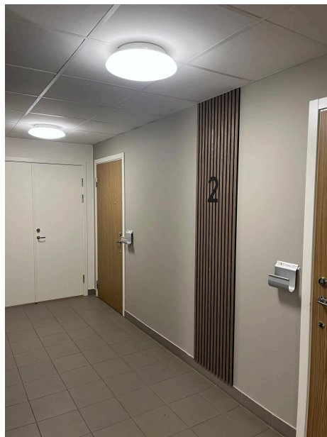
Målning av fondvägg + akustikpanel på våningsplan
