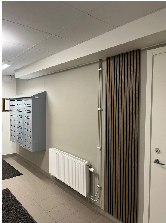
Målning av fondvägg + akustikpanel i entré
